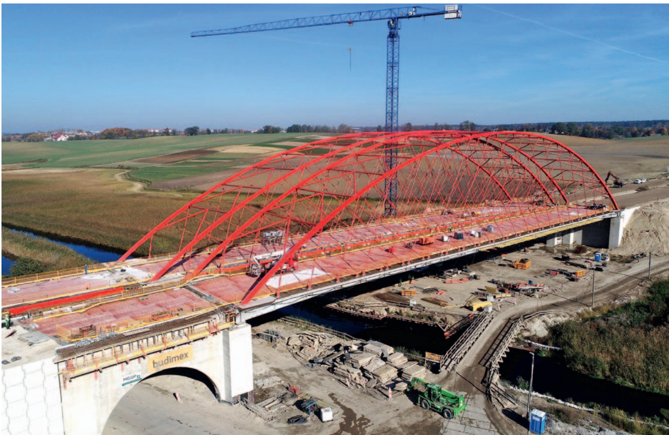
Rys. 8. Widok ogólny mostu MS-15 na zakończenie robót zasadniczych
