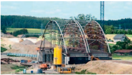
Rys. 1. Widoki ogólne mostu MS-15 w trakcie realizacji robót
