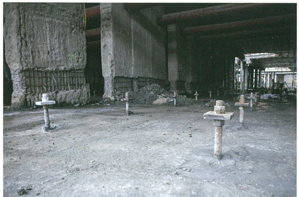
Rys. 12. Mikropale w segmencie 13
