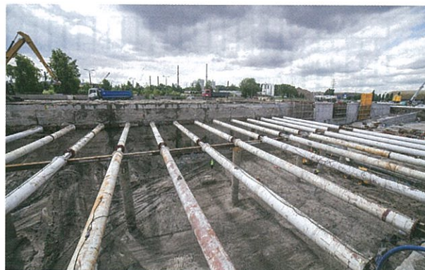
Rys. 5. Stalowa konstrukcja rozparcia ścian szczelinowych w sekcjach WU i WM
