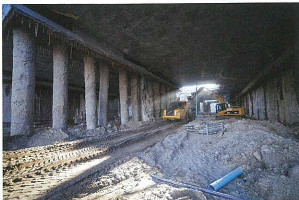
Rys. 21. Wykop podstropowy
