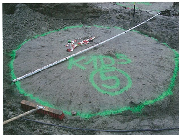
Rys. 8. Odkrywka próbnej kolumny Soilcrete
