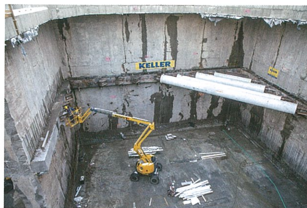
Rys. 3. Demontaż stalowego rozparcia po wykonaniu płyty fundamentowej w komorze startowej
