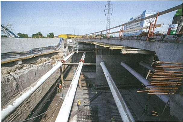
Rys. 6. Rozparcie ścian szczelinowych na węźle drogowym Marynarki Polskiej
