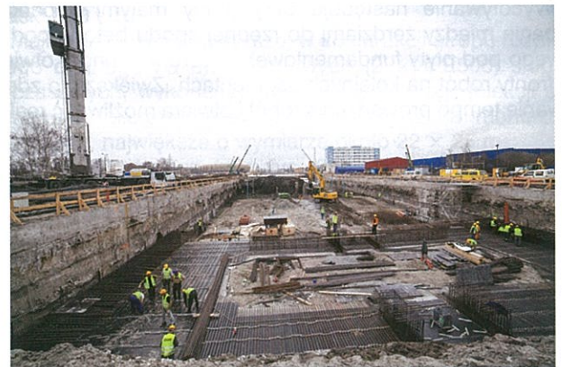
Rys. 19. Zbrojenie stropu w segmencie 30
