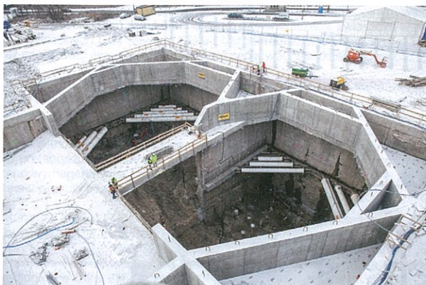
Rys. 2. Komora startowa; dwa poziomy rozparcia
