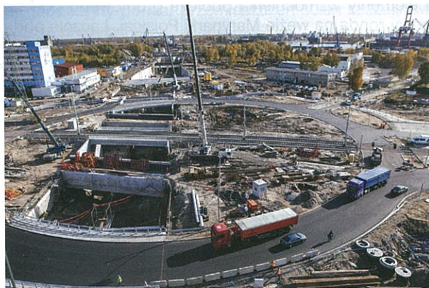
Rys. 7. Węzeł Marynarki Polskiej; ściany tunelu rozparte konstrukcjami obiektów mostowych
