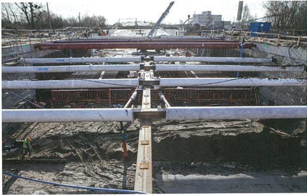
Rys. 14. Zbrojenie płyty fundamentowej; połączenie z Trasą Sucharskiego od strony mostu podwieszonoego
