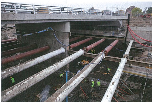
Rys. 18. Wiadukt drogowy – zbrojenie płyty fundamentowej
