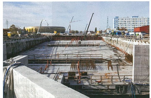
Rys. 20. Widok z szybu wyjściowego w segmencie 28 na zabetonowane stropy segmentów 29÷35
