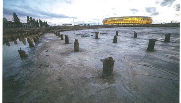
Rys. 10. Mikropale betonowe pod płytą fundamentową tunelu
