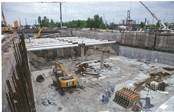
Rys. 15. Zabetonowana płyta fundamentowa i faza I ściany zewnętrznej
