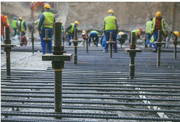
Rys. 9. Elementy zakotwienia ekranu przeciwnofiltracyjnego i płyty fundamentowej
