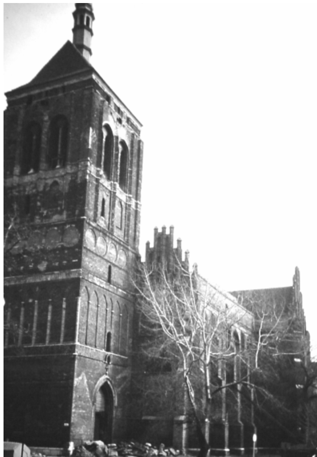
Rys. 1 Widok kościoła św. Jana w Gdańsku od strony zachodniej.
