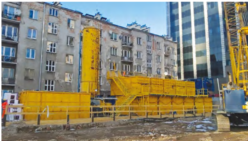
Zaplecze technologiczne Keller Polska w technologii ścian szczelinowych
