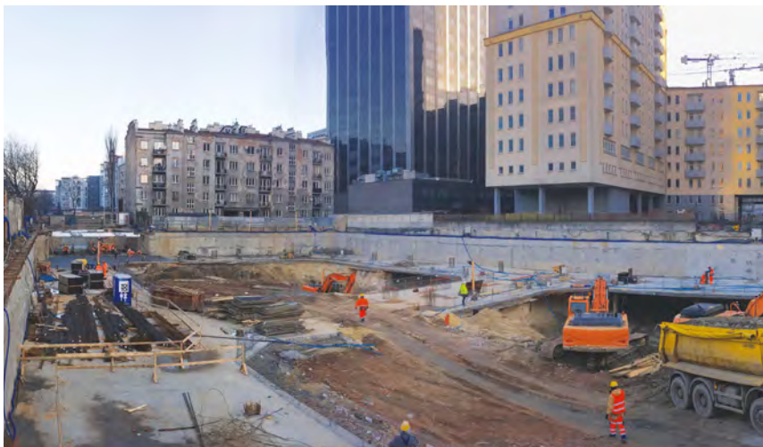
Prace na budowie, lato 2018 r.
