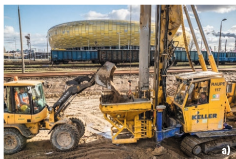
FOT. 1. | Wzmocnienie podłoża gruntowego pod torami w technologii kolumn żwirowych (a) oraz jet grouting (Soilcrete®) (b). Źródło: Keller Polska
