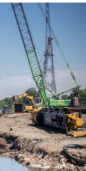
FOT. 6. | Zagęszczanie dynamiczne IC na budowie terminala kontenerowego DCT2 w Gdańsku. Źródło: Keller Polska
