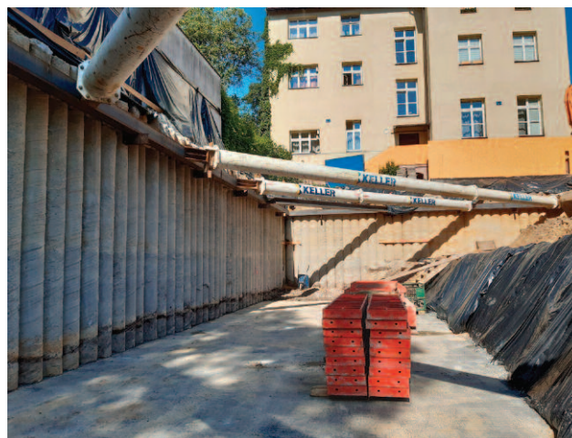
Fot. 2. Obudowa wykopu w postaci palisady z pali CCFA
