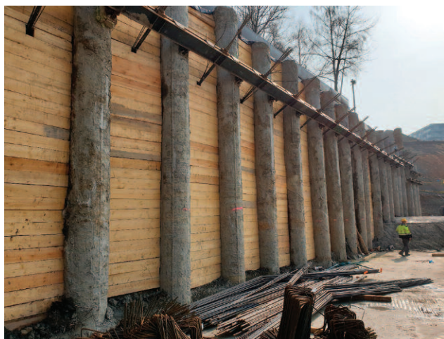
Fot. 1. Kotwiona obudowa berlińska z pali CFA
