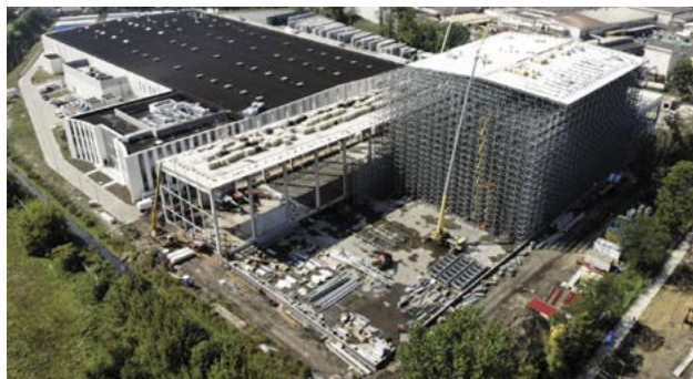
3 Magazyn wysokiego składowania w trakcie budowy
