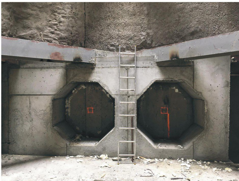
Rys. 3. a) Konstrukcja żelbetowa wykonana na potrzeby przewiertu przez ścianę szczelinową b) Kład ściany szczelinowej prezentujący położenie zbrojenia kompozytowego w koszu zbrojeniowym – Projekt Wykonawczy Keller Polska. Fot. Keller Polska.
