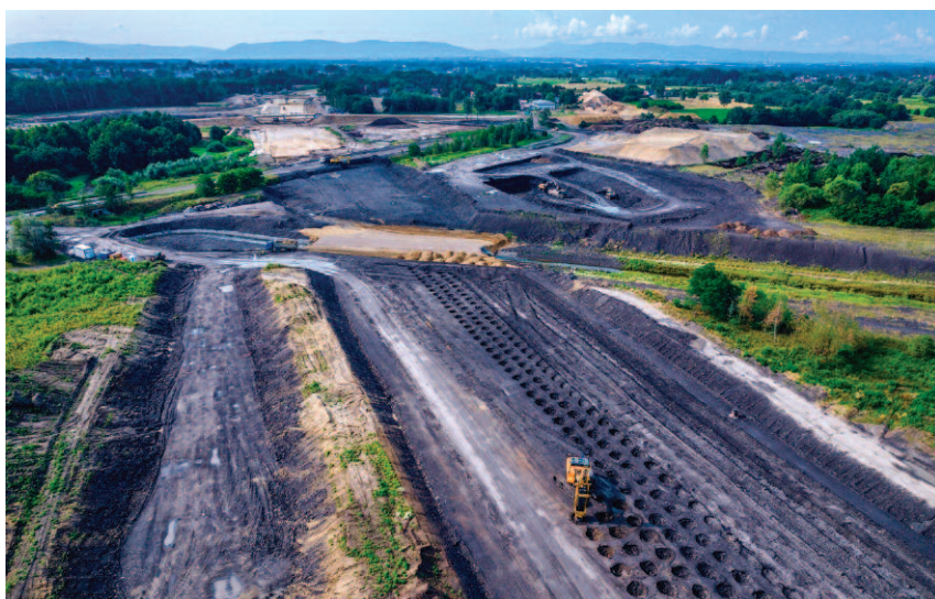
Fot. 1. Wykorzystanie technologii zagęszczania impulsowego w celu wzmocnienia podłoża pod nasyp drogowy
