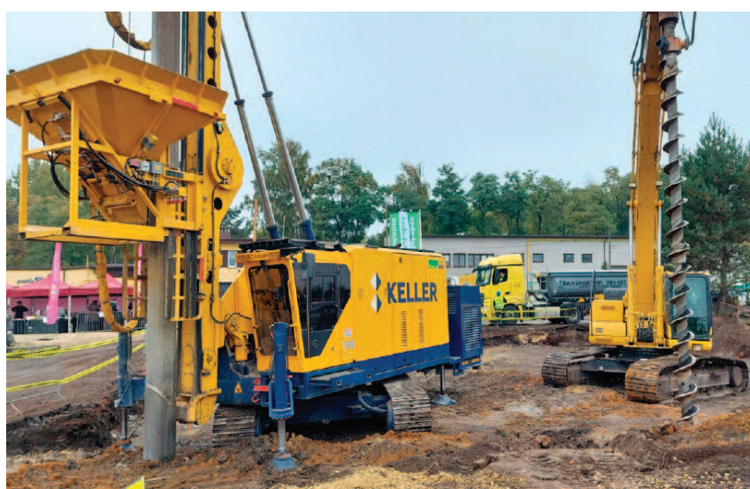
Fot. 2. Pałownica do wykonywania kolumn żwirowych oraz koparka do podwiertów
