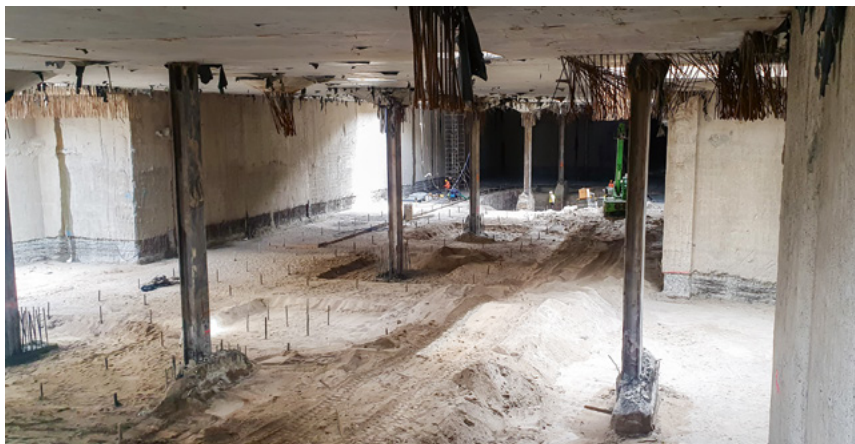
FOT. 6. | Poziom -3 przystanku osobowego Koziny FOT. 7. | Odślonięta wewnętrzna powierzchnia ściany szczelinowej po zabiegach rektyfikacyjnych
