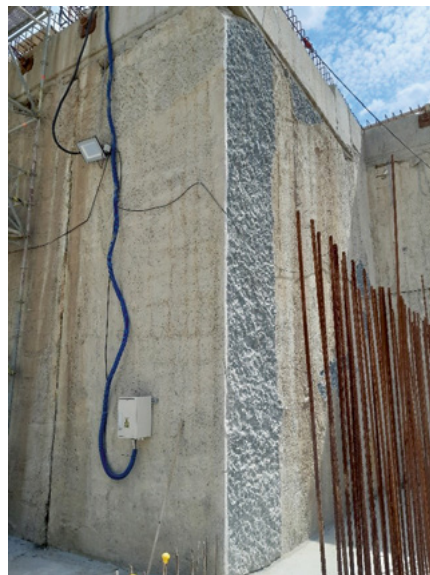
FOT. 6. | Poziom -3 przystanku osobowego Koziny FOT. 7. | Odślonięta wewnętrzna powierzchnia ściany szczelinowej po zabiegach rektyfikacyjnych
