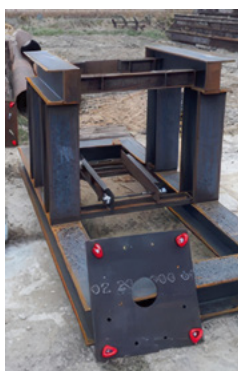
FOT. 10-11. | Po lewej stronie rama stalowa do montażu docelowych słupów stalowych, po prawej „przedłużacz”
