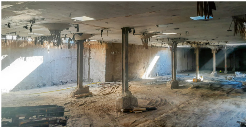
FOT. 8-9. | Po lewej stronie widoczne głowice baret fundamentowych bezpośrednio po usunięciu gruntu, po prawej natomiast skuta głowica baret fundamentowej
