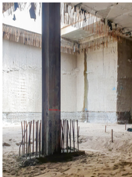
FOT. 8-9. | Po lewej stronie widoczne głowice baret fundamentowych bezpośrednio po usunięciu gruntu, po prawej natomiast skuta głowica baret fundamentowej
