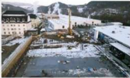
Przykład organizacji platformy roboczej, fot. Keller Polska Sp. z o.o.
