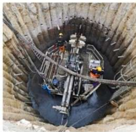
Ryc. 4. Instalacja poziomych rur iniekcyjnych
