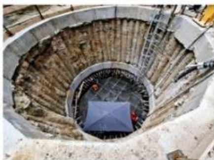
Ryc. 5. Pompowanie iniektu do rur iniekcyjnych
