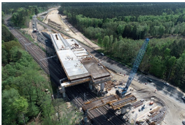
Fot. 1. Obiekt W13, stan na kwiecień 2024 r. Źródło: GDDKiA
