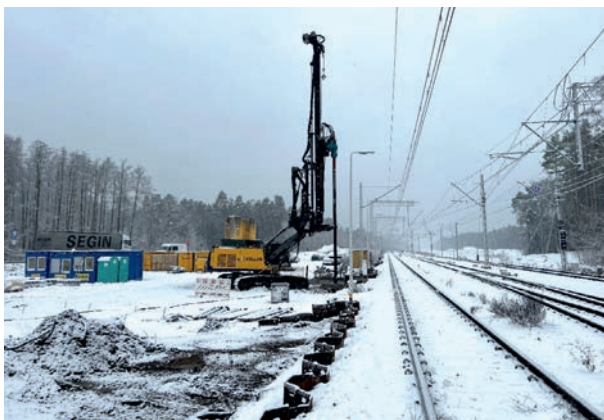
Fot. 2. Ograniczona przestrzeń z uwagi na sąsiedztwo istniejącej linii kolejowej
