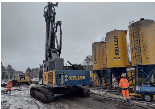
Fot. 3. Palownica Liebherr 125 wraz z zapleczem technologicznym do wytwarzania zaczynu cementowego
