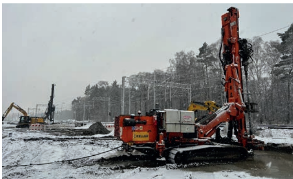
Fot. 4. Wykonanie mikropali w świeżych kolumnach cementowo-gruntowych DSM
