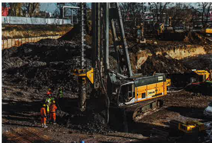
Rys. 4. Wykonawstwo pali CFA pod posadowienie Warta Towers (fot. Keller Polska)
