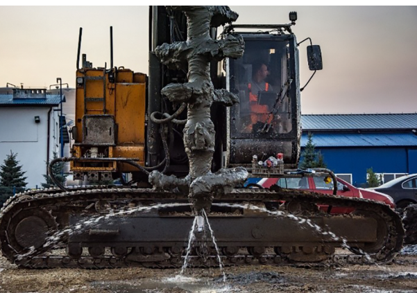
FOT. 2. | Wiertnica z osprzętem do wykonania kolumn SCC oraz mieszadło podczas zagłębienia (Fot. Keller)
