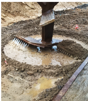
FOT. 2. | Wiertnica z osprzętem do wykonania kolumn SCC oraz mieszadło podczas zagłębienia (Fot. Keller)
