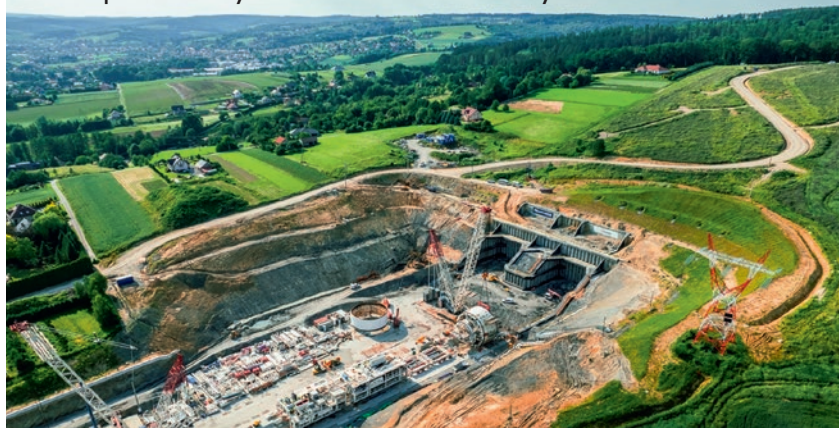
Portal południowy tunelu w trakcie budowy – Babica
