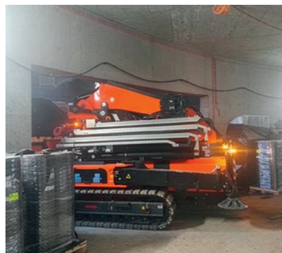
Fot. 2. Maszyna hydrauliczna do demontażu rozpór
