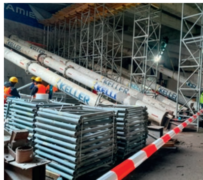
Fot. 1. Tymczasowa stalowa konstrukcja rozparcia, demontowana spod stropu kondygnacji podziemnej
