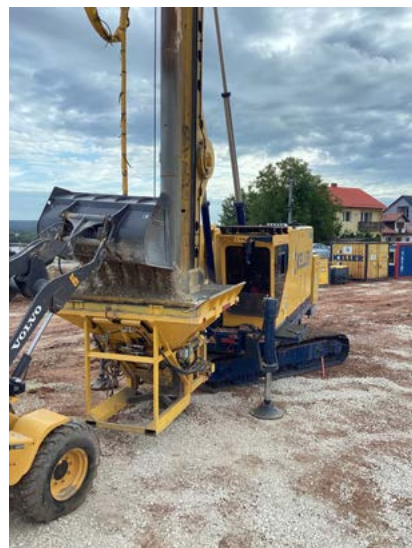
FOT. 3. | Wykonywanie kolumn z przekruszu betonowego
