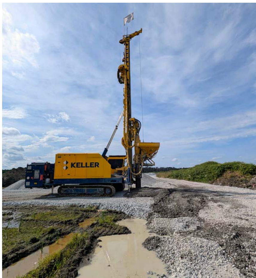
FOT. 4. | Wykonywanie kolumn żwirowych (KSS) w warunkach gruntów nawodnionych – technologia pełni jednocześnie funkcję wzmocnienia i efektywnego drenażu podłoża
