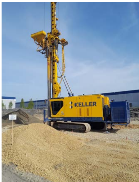
FOT. 5. | Maszyna specjalistyczna do wykonywania kolumn żwirowych
