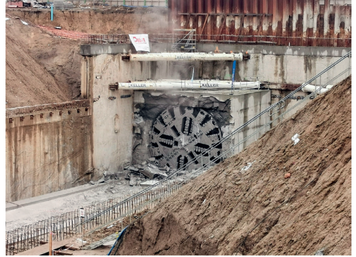
Fot. 2. Przebieg TBM przez stację Koziny
