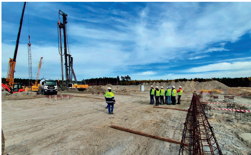
Wizyta na budowie Keller
